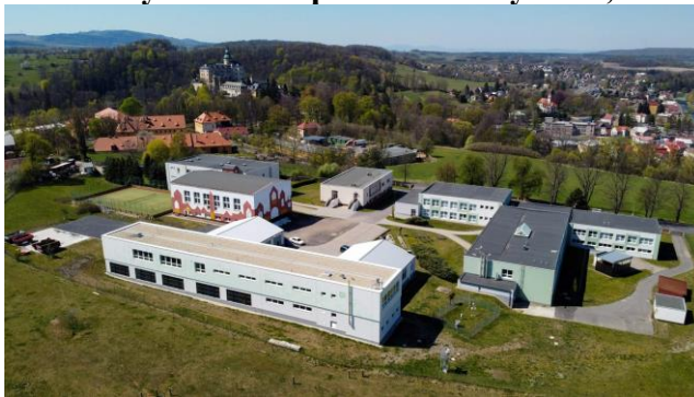
Budovy školy, Bělíkova, Frýdlant
