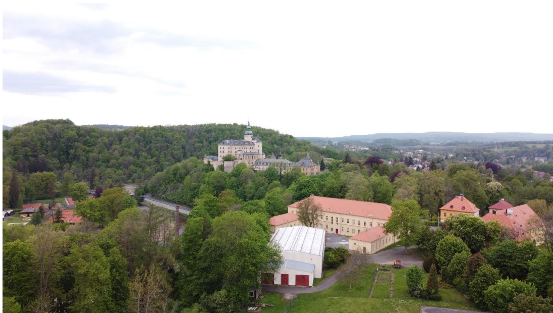
Budovy školy, Zámecká, Frýdlant
