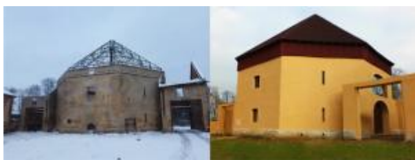
Sýpky před a po rekonstrukci
